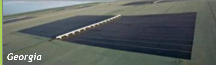
Solar geomembrane capping landfill
